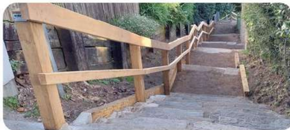
PLANCOËT : CHANTIER SENTE ET ESCALIER À SAINT-CAST-LE-GUILD
